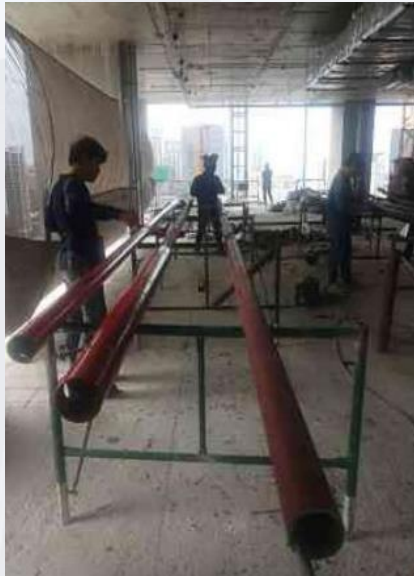
งานเดินท่อระบบดับเพลิงโรงงาน
