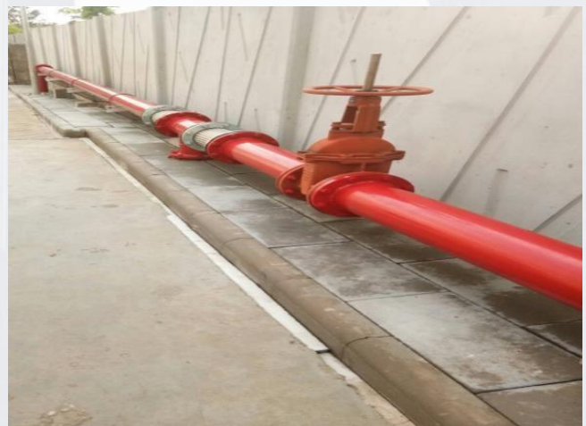
งานเดินท่อระบบดับเพลิงโรงงาน
